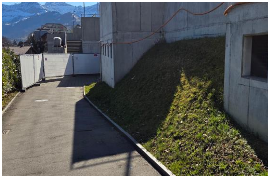
Bild 3. Weiterer potentieller Bereich für Begrünung
