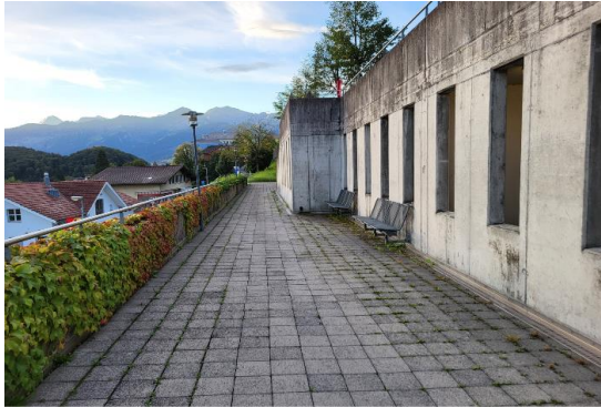
Bild 1: Durchgang, vor ehemaliger Bar / Velo-Parking
